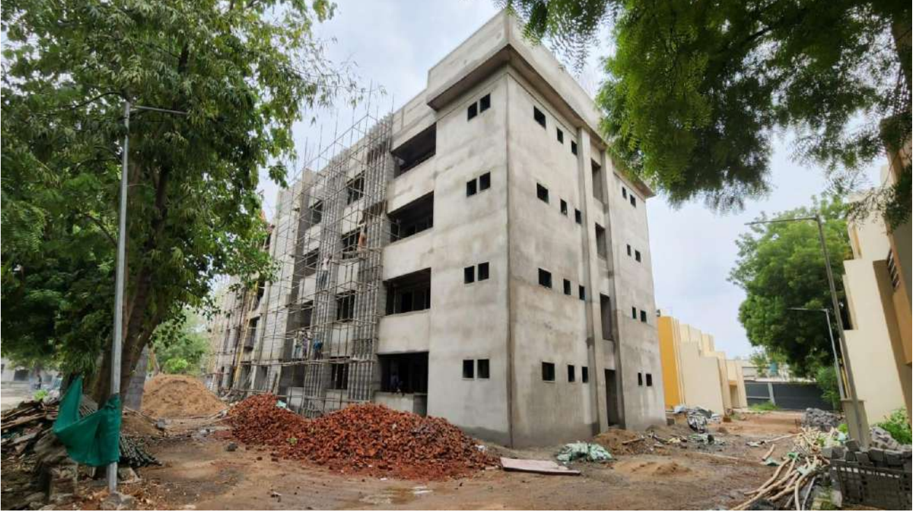
नये होस्टेल बिल्डींग का निर्माण
